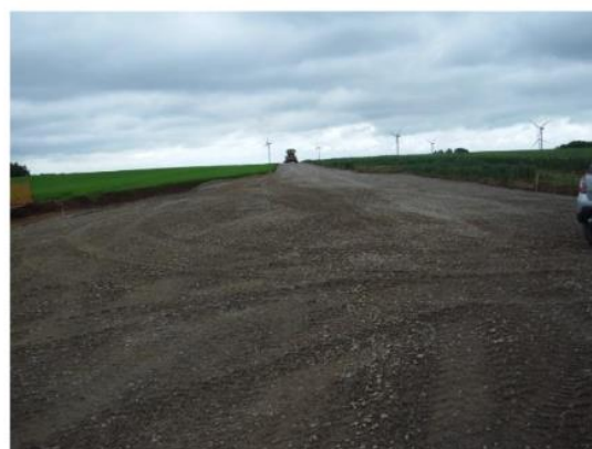
Chemin de chantier
