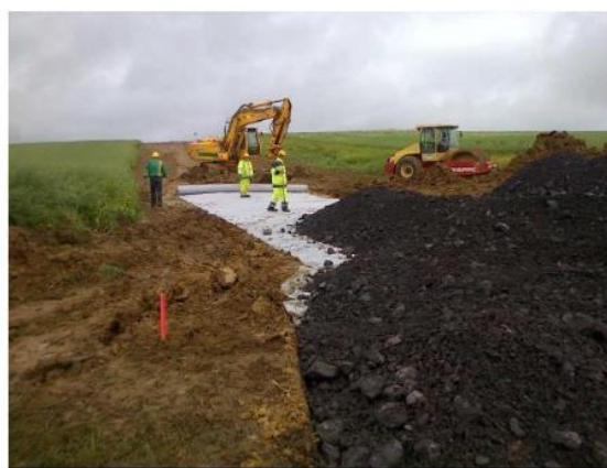
Pose d'un géotextile
